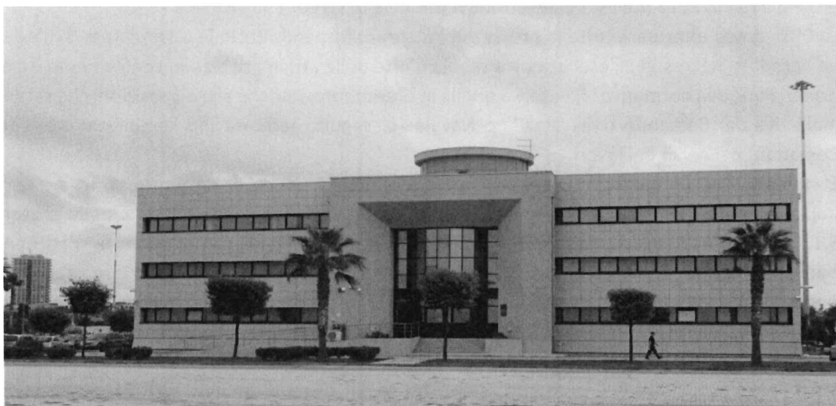
Foto 1 – Edificio 1 bis – COMDINAV DUE
